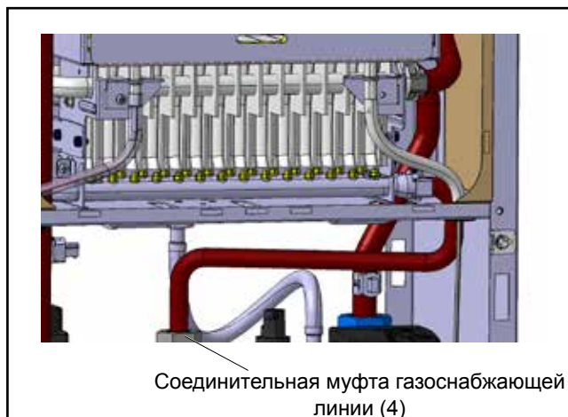
Рис.: Очистка газовой горелки
