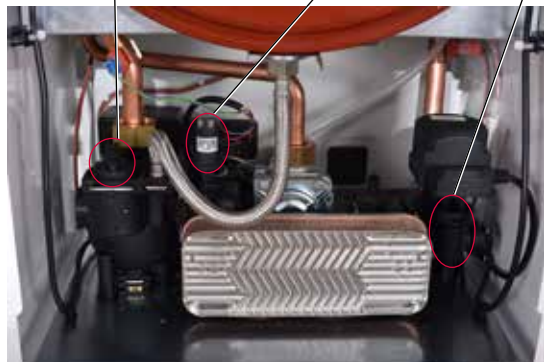
Клапан заполнения Сливной клапан
